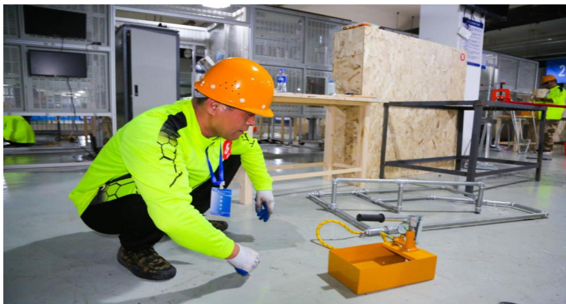
管工赛项参赛选手正在对安装好的管道进行压力测试
